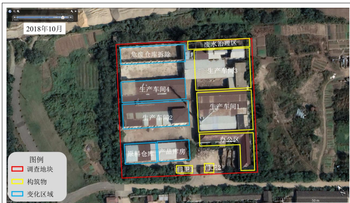
2018年10月，地块左侧构筑物开始陆续拆除；
